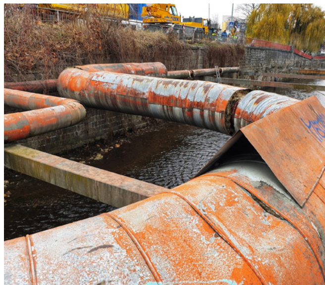
V rámci projektu GreenNet došlo k odstranění nevzhledných starých parovodů z koryta řeky Nisy. Kultivace veřejného prostoru bude pokračovat stavbou náplavky u krajského úřadu.
