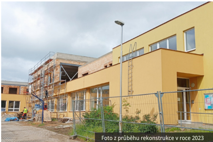
Foto z průběhu rekonstrukce v roce 2023
