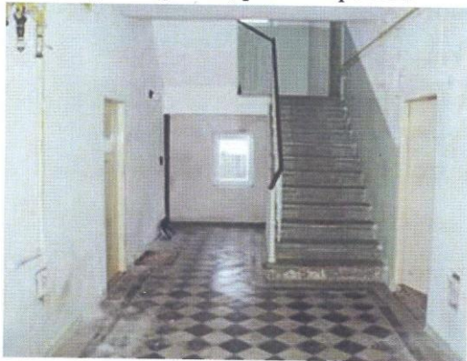
1.N.P., chodba se schodištěm
