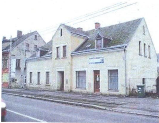
Objekt č.p. 261, průčelní pohled
