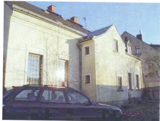
Objekt č.p. 261, zadní pohled
