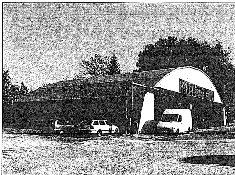
Pohled na halu od západu z přístupové komunikace
